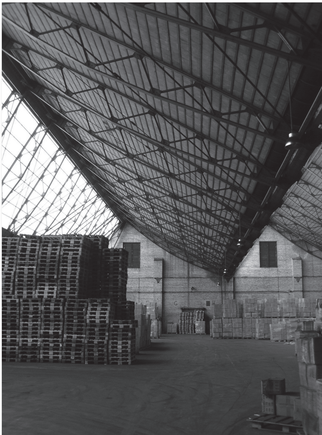
Le plafond suspendu des entrepôts de la gare maritime, Bruxelles (Photo : Gracia Dorel-Ferré)
